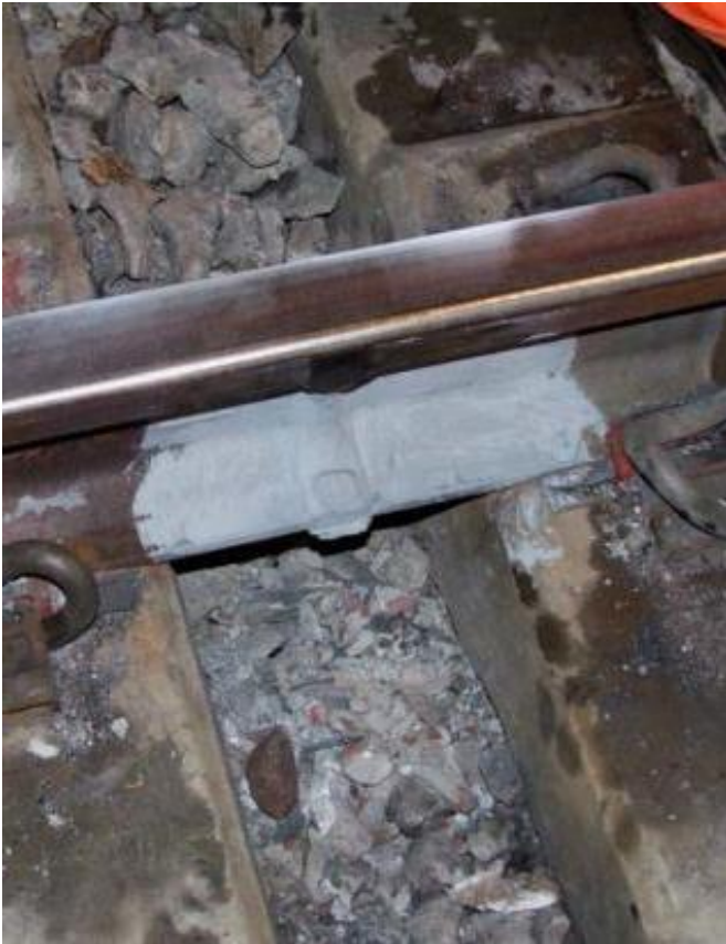
Esempio della procedura di "ritocco" applicata a una saldatura aluminotermica. N.B. L'immagine è di una guida non rivestita per evidenziare l'area di "ritocco".
